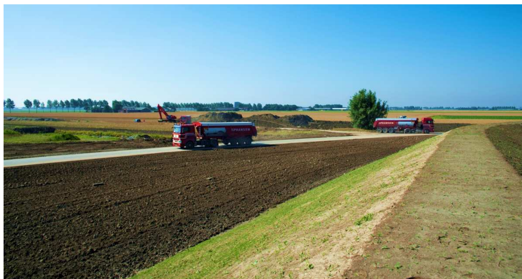
Aanleg grondwal Pioniers en verhoogde parklaag in deelgebied 1
